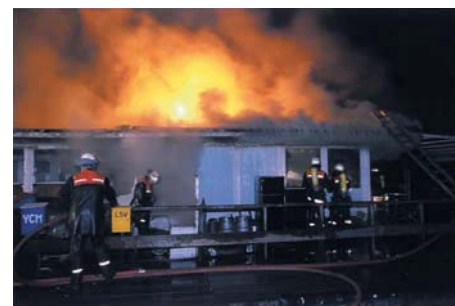
Obr. 1: Požár restaurace Aussenalster v Hamburku Budova: Převážně dřevěná, jednopatrová, Postavená na dřevěných pilotech Příčina požáru: Technická závada elektroinstalace, pravděpodobně následkem únavy materiálu Škody na budově: Zničení až na piloty a trámový rošt Výše škody: cca. 0,5 mil. EUR
